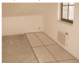
1. Amplasare izolație
