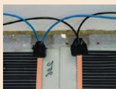
conexiune ECOFILM F în paralel, izolată cu Mastic
